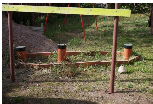
Рис.2. Трёхкамерный септик у частного дома.
